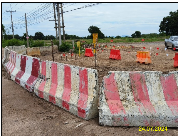
ติดตั้งวัสดุกันโดยรอบเขตพื้นที่ก่อสร้าง
