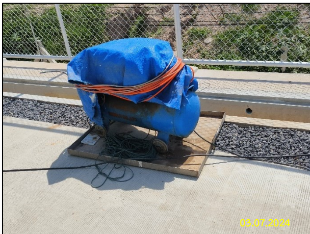
รูปที่ 2-8 การจัดเตรียมถาดเก็บและรองรับน้ำมัน พร้อมวัสดุดูดซับ
