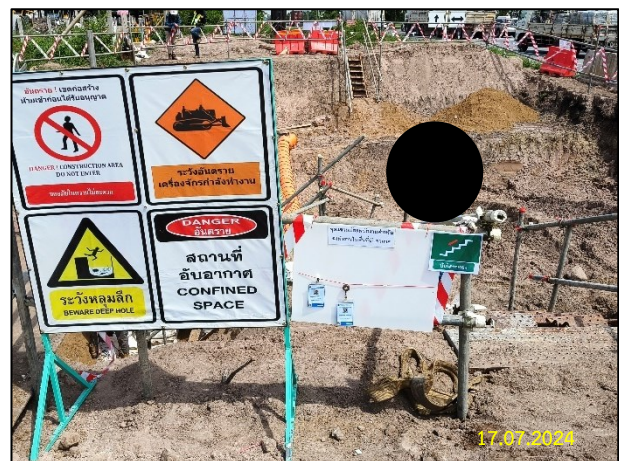
การกันเขต พร้อมติดตั้งเครื่องหมายเตือนแสดงเขตหวงห้ามบริเวณพื้นที่ที่มีการเชื่อมต่อ
