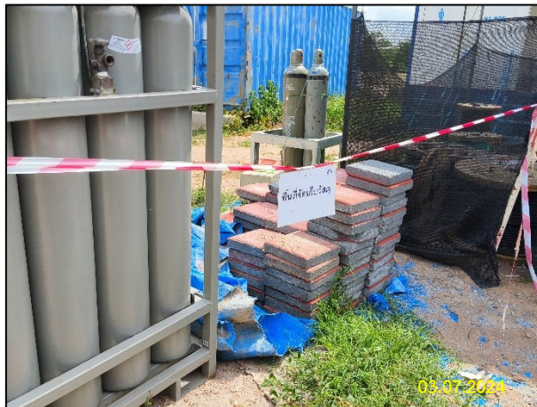
รูปที่ 2-13 จัดวางกองวัสดุที่ใช้ในการก่อสร้างไม่ให้เกิดขวางทางระบายน้ำ
