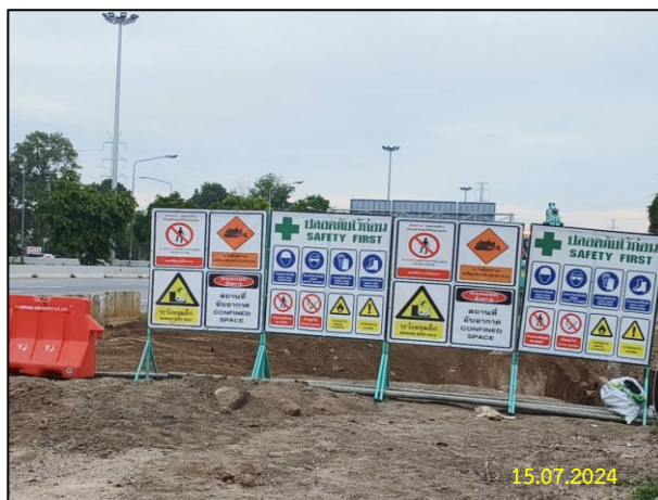
การกันเขต พร้อมติดตั้งเครื่องหมายเตือนแสดงเขตหวงห้ามบริเวณพื้นที่ที่มีการเชื่อมต่อ
