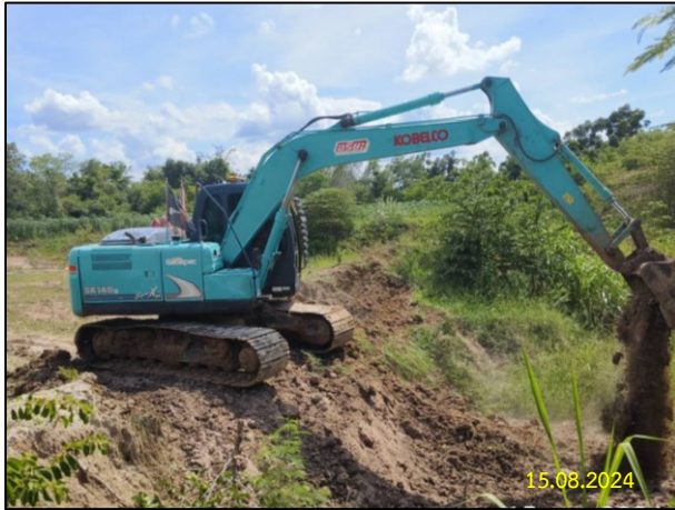
การฝังกลบหรือปิดคลุมบ่อทิ้งโคลนโซเดียมเบนโทไนท์เมื่อใช้พื้นที่แล้วเสร็จ รูปที่ 2-15 การจัดการโคลนโซเดียมเบนโทไนท์ของโครงการ
