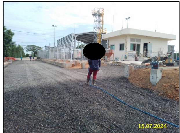
รูปที่ 2-2 การฉีดพรมน้ำบริเวณพื้นที่ก่อสร้างและเส้นทางคมนาคมในบริเวณใกล้เคียงพื้นที่ก่อสร้าง
