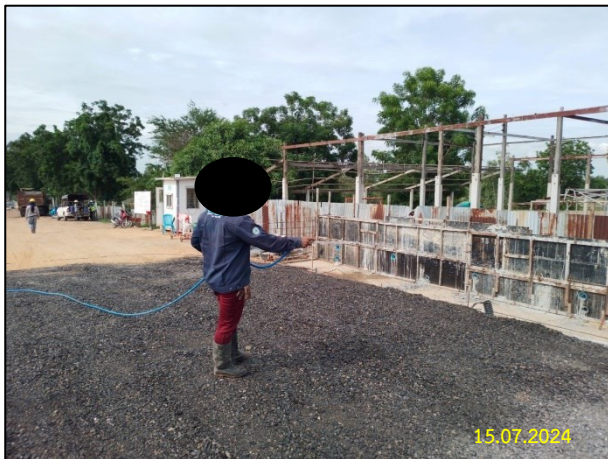
รูปที่ 2-2 การฉีดพรมน้ำบริเวณพื้นที่ก่อสร้างและเส้นทางคมนาคมในบริเวณใกล้เคียงพื้นที่ก่อสร้าง
