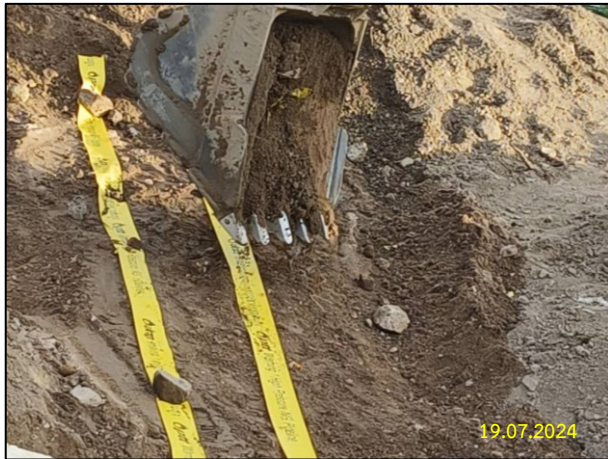
การวางแถบสีเหลือง (Warning Tape) และฝังแผ่นคอนกรีตเหนือแนวท่อ
